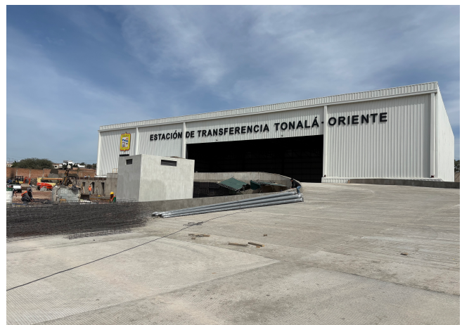
Ilustración 22. Construcción de la Estación de Transferencia Oriente.
